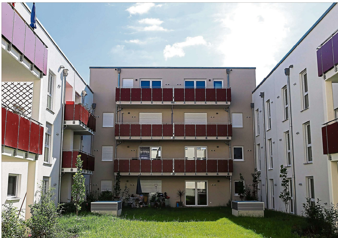
WBG-Großprojekt an der Wittelsbacherhöhe: Für 7,5 Millionen Euro wurden 46 Wohnungen mit rund 3000 Quadratmeter Wohnfläche gebaut. Foto: Daniela Bast
